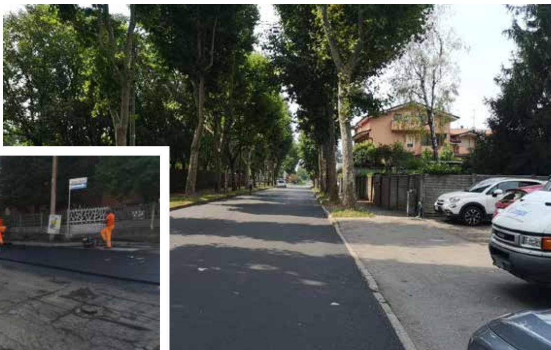
I lavori in Via Lombardia
