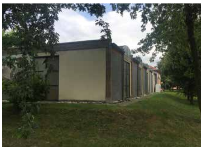
■ Il completamento dei lavori alla bocciofila
