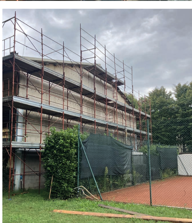
■ lavori di riqualificazione campi da tennis ed ex bocciola
